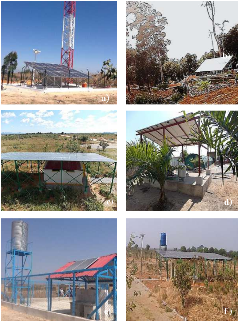
Figura 3 – Instalações com aproveitamento de energia solar existentes no município do Huambo - a) Painéis fotovoltaicos servindo antena de comunicações (comuna da Calima); b) Sistema híbrido (energia solar e eólica) existente em quinta da aldeia de Cassema (comuna da Calima); c) Sistema fotovoltaico instalado na comuna da Chipipa; d) Instalação de bombagem de água para rega com painéis solares (bairro do Cambiote, comuna da Calima); e) Abastecimento de água com painéis fotovoltaicos (comuna da Calima); f) Abastecimento de água com painéis fotovoltaicos (Projecto Agro-turístico da Chipipa, comuna da Calima). Fotos: Silva (2016) .
